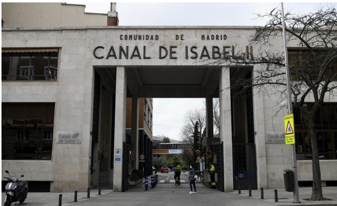
Entrada a las instalaciones del Canal Isabel II. EP
