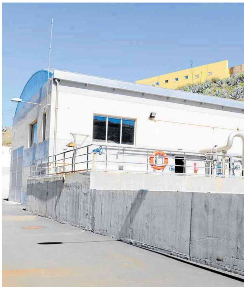
Depuradora de Las Majadillas. c7
