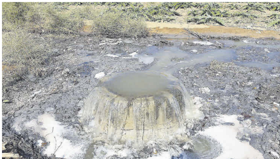
Alcantarilla taponada y desbordada por acumulación de toallitas en Murcia. / EFE
